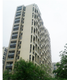
▲荣获西湖杯(建筑工程奖)的南北·乐章10#楼工程
